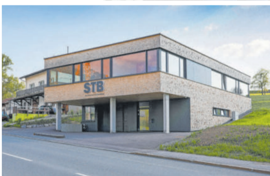
Der Neubau von STB Steuerungstechnik in Andelsbuch entstand 2018. STB/STEINLECHNER
